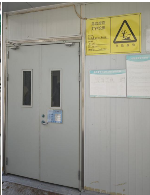
危废暂存间（外部）
